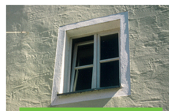
Putzarchitektur ist Baukultur. Ein handwerklicher (hier brettgestoßener) Außenputz in Verbindung mit der ortstypischen Putzgliederung verleiht jeder Außenwand eine Lebendigkeit und Spannung, die kein Maschinenputz erreicht.
